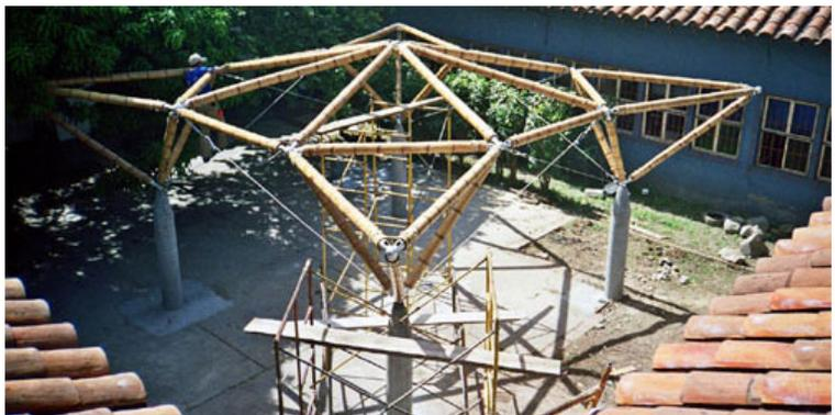
Fig.55 - estructura completa
