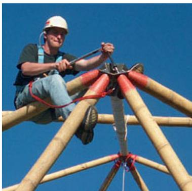
Fig. 20 - unión con platina - C.Tönges
