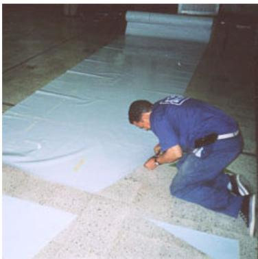
Fig.47 - corte des los moldes de la tela
