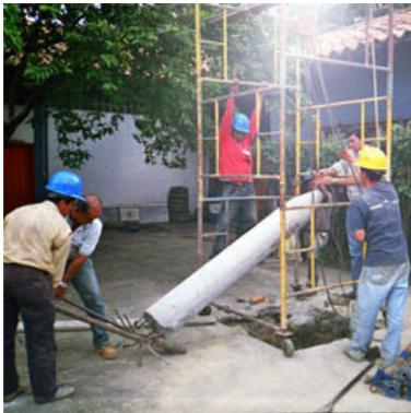
Fig.44 -montaje de las columnas
