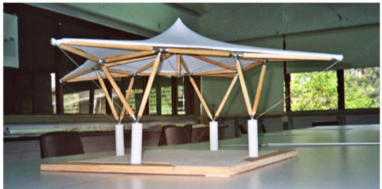
Fig.39-octágono con 4 tetraeders horizontales + membrana maqueta
