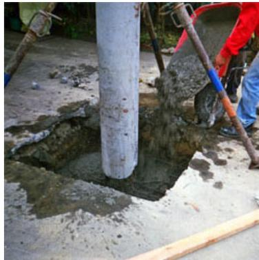
Fig.45 -montaje de las columnas
