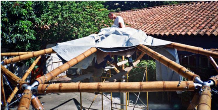
Fig.56 – poner la membrana sobre la estructura
