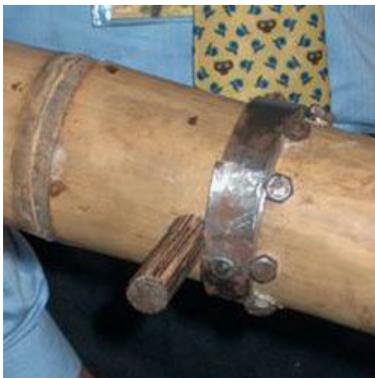
Fig.23- unión con tornillos – D.Trujillo
