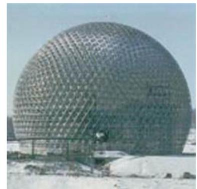
Fig.33-cúpula geodésica de acero
