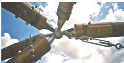
Fotografía 14: Detalle unión; Bamboo-Space
