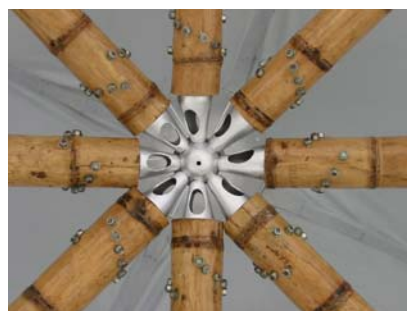
Fotografía 13: Detalle unión; Bamboo-Space
